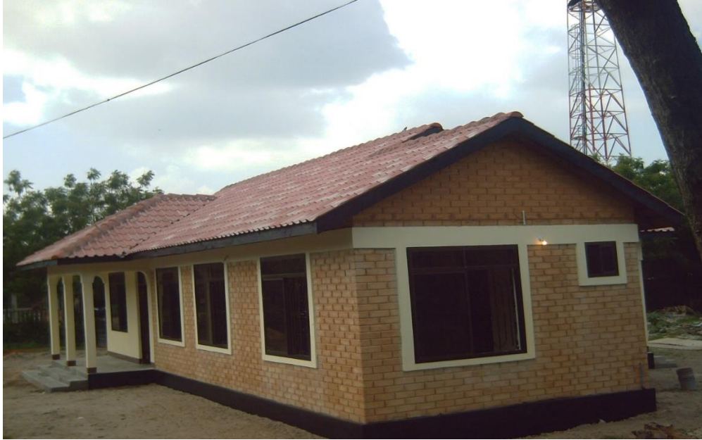
Nyumba ya Askari wa FFU Ukonga -Dar es salaam iliyojengwa kwa kutumia matofali ya kufungamana na vigae mkonge
