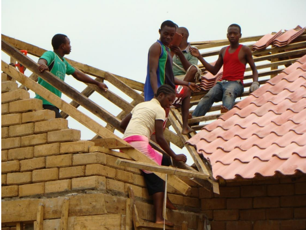
Wanasemina wakiwa katika mafunzo ya vitendo ya upauaji wa nyumba kwa kutumia vigae mkonge huko Msoga mkoani Pwani
